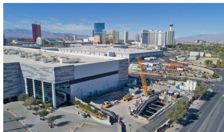
Baustelle des LVCC
