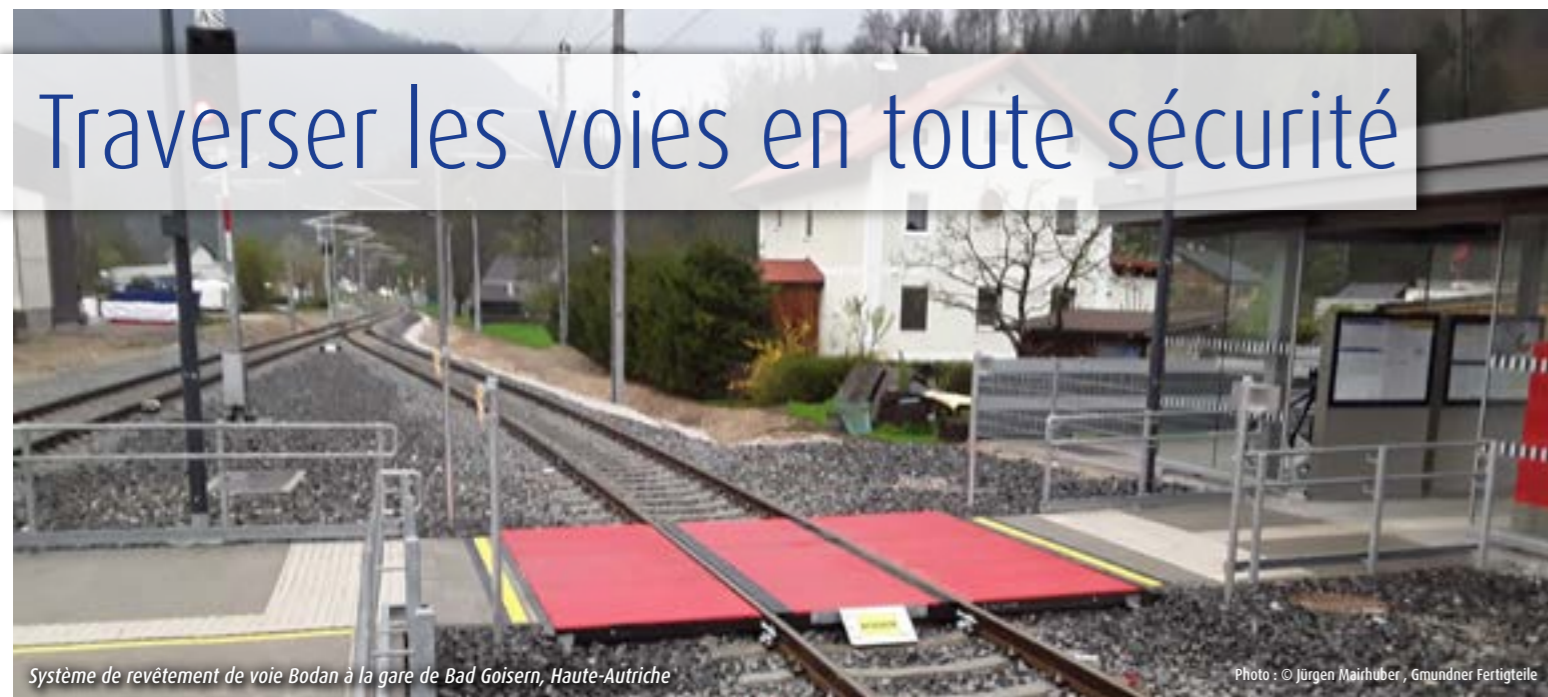
Système de revêtement de voie Bodan à la gare de Bad Gaisern, Haute-Autriche
