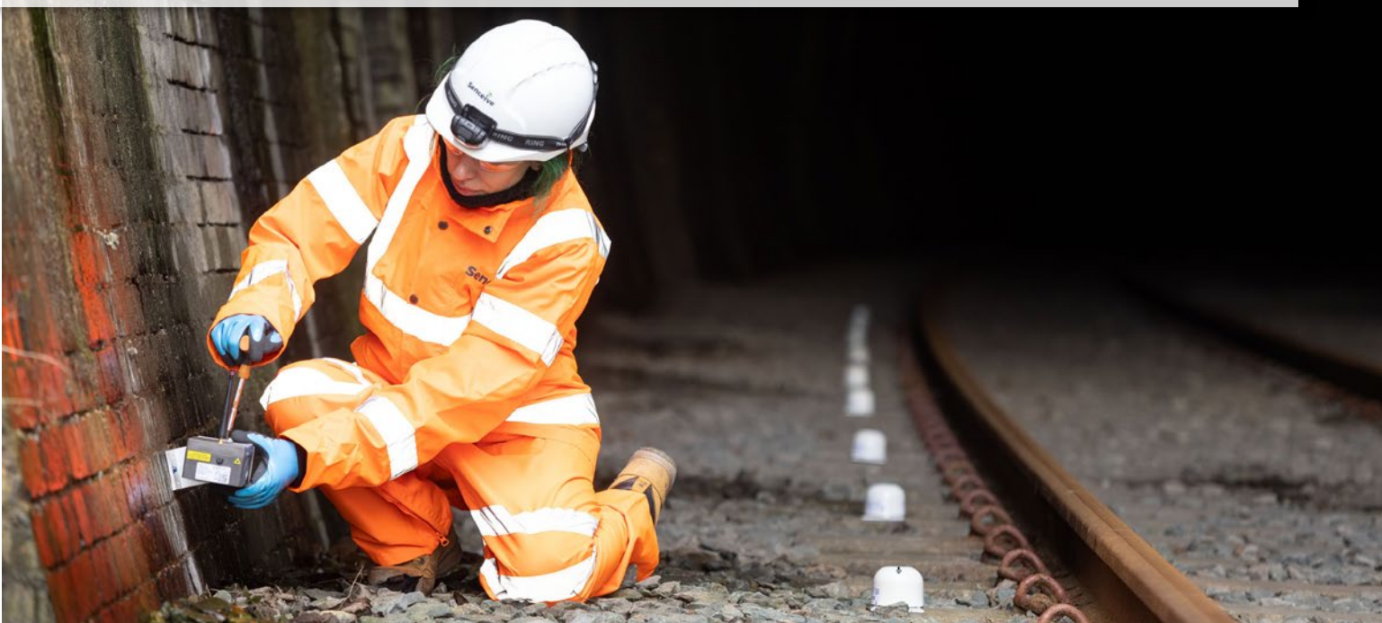
Capteurs pour la surveillance des tunnels
